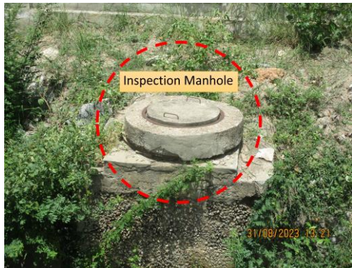
รูปที่ 5 ป่อตรวจสอบคุณภาพน้ำทิ้ง (Inspection Manhole)
