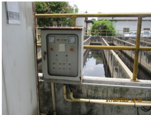
รูปที่ 6 อุปกรณ์ตรวจวัดคุณภาพน้ำ Online ได้แก่ pH, SS, BOD, และ COD
