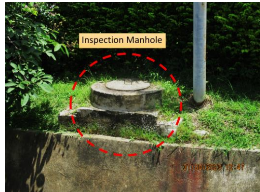
รูปที่ 5 ป่อตรวจสอบคุณภาพน้ำทิ้ง (Inspection Manhole)
