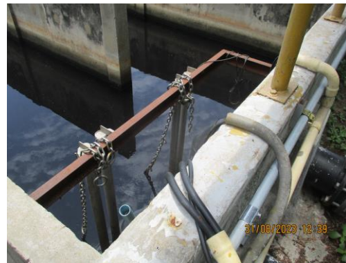
รูปที่ 6 อุปกรณ์ตรวจวัดคุณภาพน้ำ Online ได้แก่ pH, SS, BOD, และ COD
